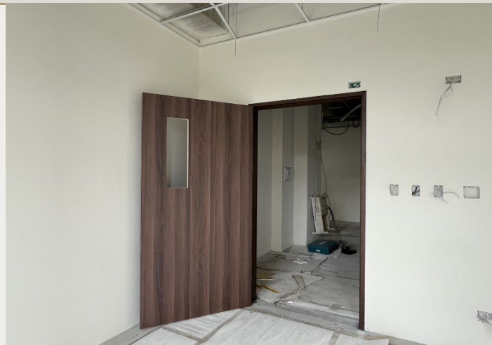
各空間木門扇安裝
