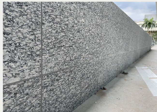
南向入口石材掛裝矽利康打設完成
