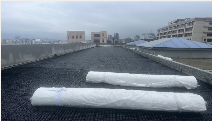
屋頂植栽綠化區排水版鋪設
